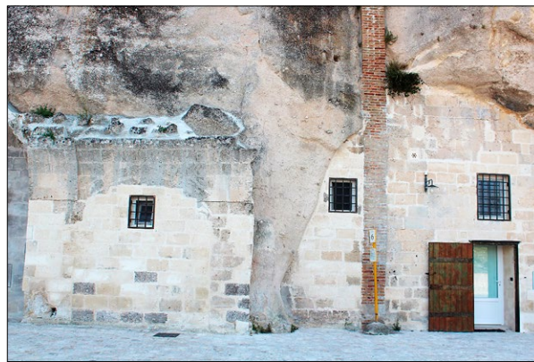
Ryc. 10. Fragmentaryczna elewacja domostwa wykutego w skale; fot. M. Stachurska 2019.
