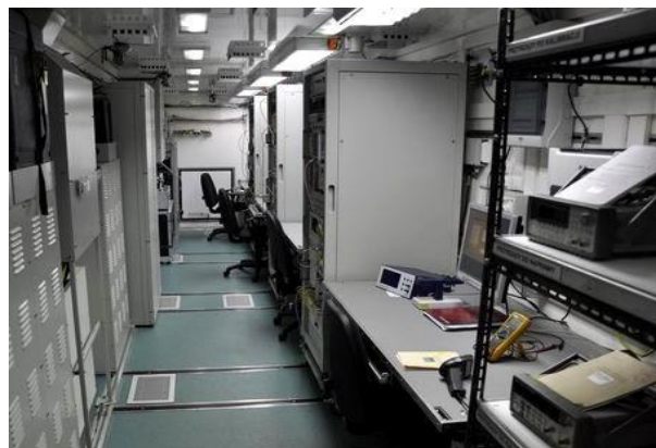
Fot. 6. Widok ogólny przedziału metrologicznego
