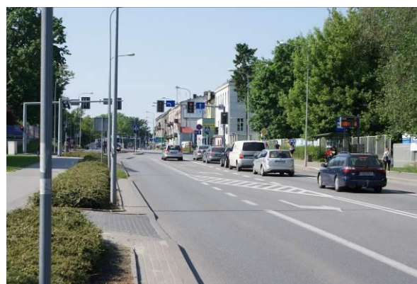
Fot. 4. Ulica Malczewskiego - punkt pomiarowy [fot. T. Perzyński]
