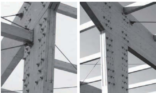
Rys. 31. Połączenia na sworznie i śruby [13]
