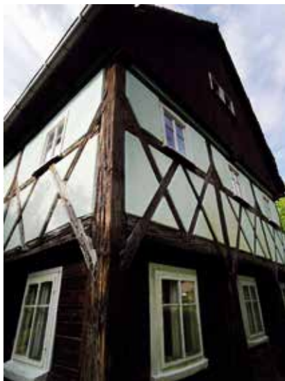
Fot. 2. Narożnik izby zrębowej z widocznymi trzema rodzajami konstrukcji; źródło: [12]
