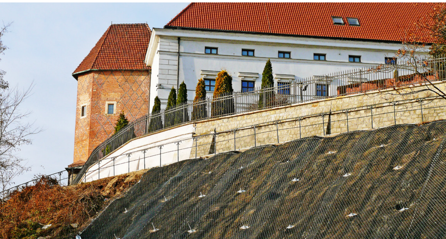
Stabilizacja skarpy osuwiskowej wokół zamku w Sandomierzu, gdzie wykorzystano system gwoździ gruntowych wraz z siatką stalową. Osuwiska są zagrożeniem nie tylko dla nowo powstających inwestycji, ale także dla budowli istniejących od wieków, fot. Ischebeck TITAN Polska
