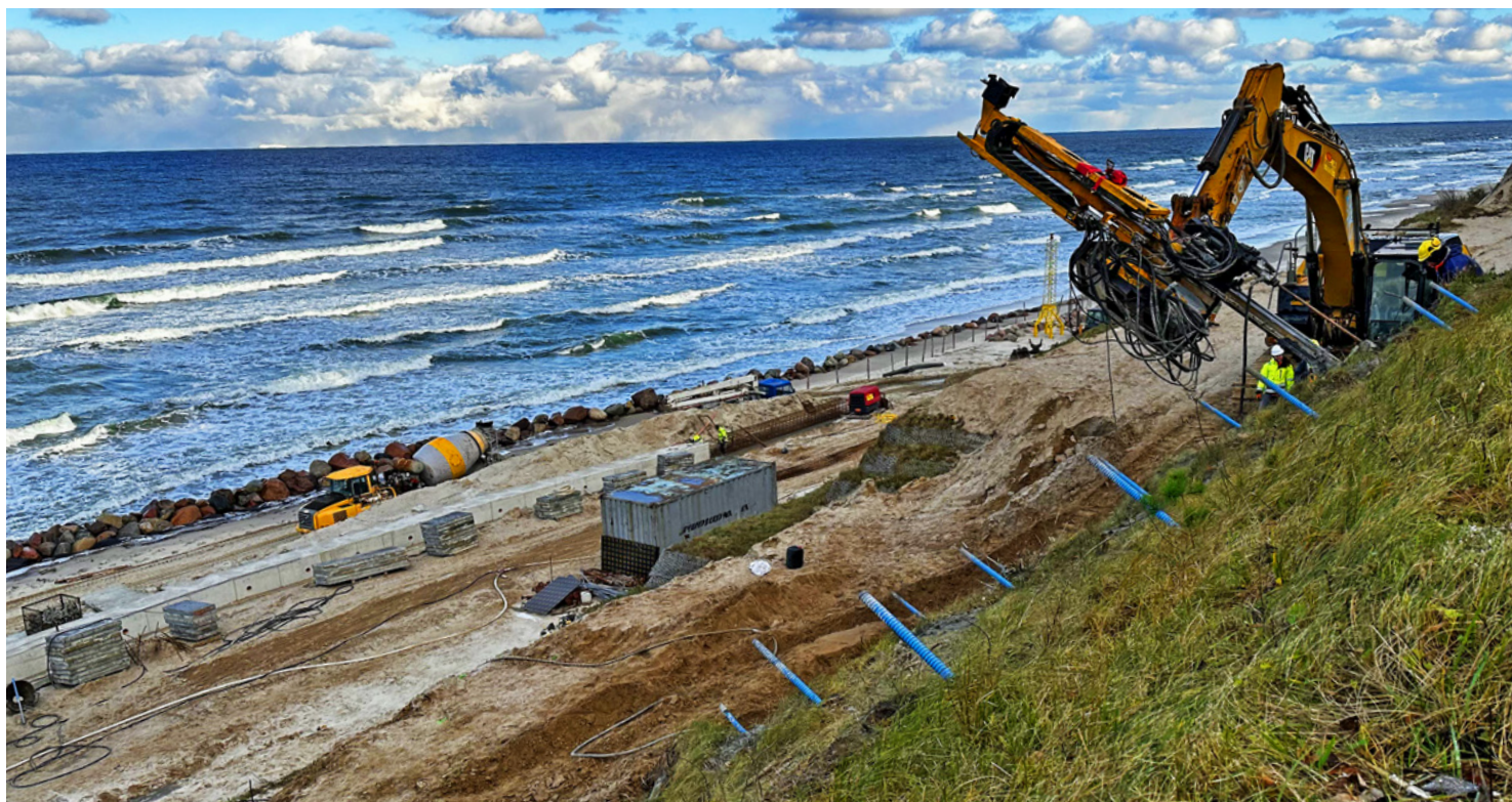
Obecnie na zlecenie Urzędu Morskiego w Gdyni realizowana jest inwestycja w Jastrzębiej Górze, której klifowe wybrzeże jest szczególnie narażone na niszczącą działalność fal. Umocnianie brzegu przez gwoździowanie, palowanie i drenaż węglony powinien zapobiec powiększaniu się istniejącego osuwiska. Wykonawcą prac jest WMW Sp. j., fot. Ischebeck TITAN Polska
