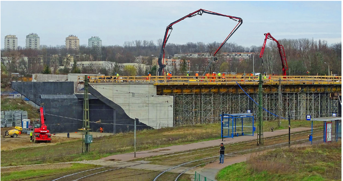
Budowa Północnej Obwodnicy Krakowa, której zadaniem jest komunikacyjne odciążenie centrum miasta, wpisuje się w ideę rozbudowy sieci dróg dla bezpieczeństwa komunikacyjnego. Zakres robót obejmuje m.in. budowę drogi ekspresowej S52 od węzła Modlnica do węzła Mistrzejowice o długości ok. 12,5 km wraz z obiektami inżynieryjnymi, rozbudowę istniejącego węzła Modlnica, budowę węzłów Zielonki, Węgrzce i Batowice oraz budowę infrastruktury dla pieszych i rowerzystów, fot. GDDKiA
