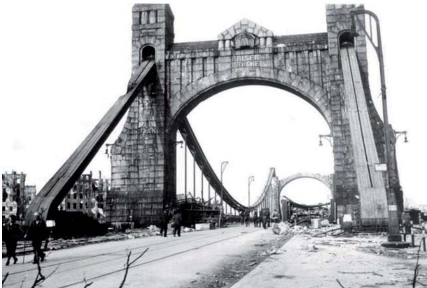
Fot. 2. Uszkodzony most Grunwaldzki w maju 1945 r.; widok z lewego brzegu rzeki (fot. Michail Litwinow, źródło: Zakład Narodowy im. Ossolińskich)
