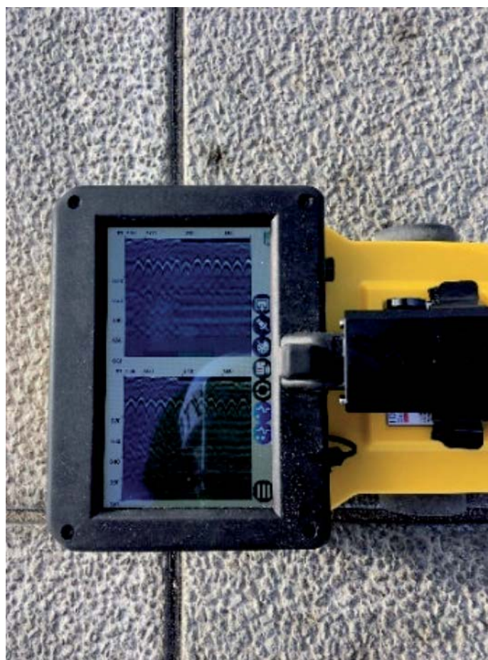
Rys. 13. Georadar z anteną o częstotliwości 2,0 GHz w trakcie badania lokalizacji kotew i dybli
