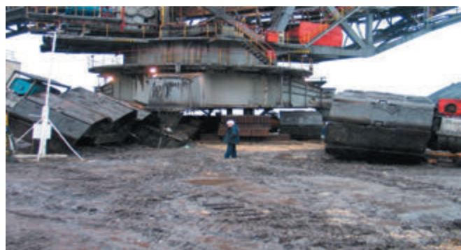
Rys. 3. Pęknięcie osi w gąsienicowym układzie jazdy zwałowarki A 2 RsB-12500
