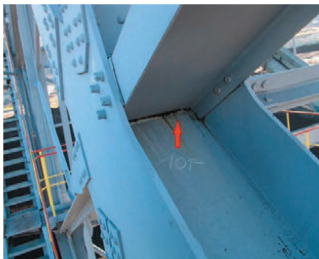
Rys. 13. Badania defektoskopowe nieniszczące: a) pęknięcie w konstrukcji wyrzutnika kamieni, b) produkty korozji, będące efektem braku odpływu wody
