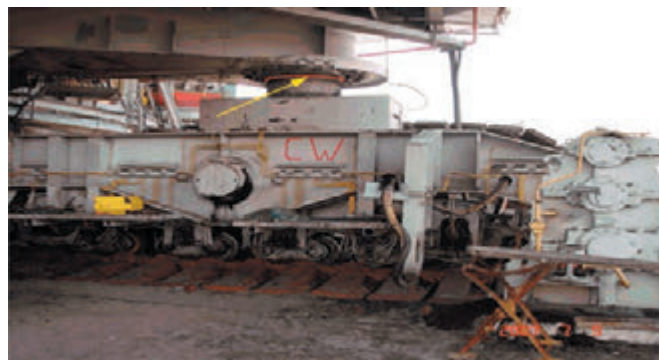
Rys. 2. Pęknięcia słupów podporowych koparki SRs-2000
