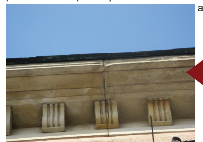
Fot. 5. Uszkodzenia tynków na powierzchniach poziomych
