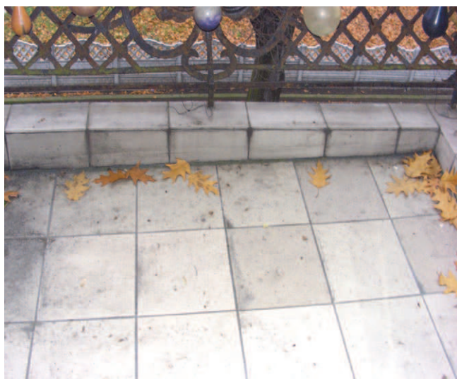
Rys. 3. Widok balkonu od góry, płyta w formie „koryta” wyłożona płytkami ceramicznymi
