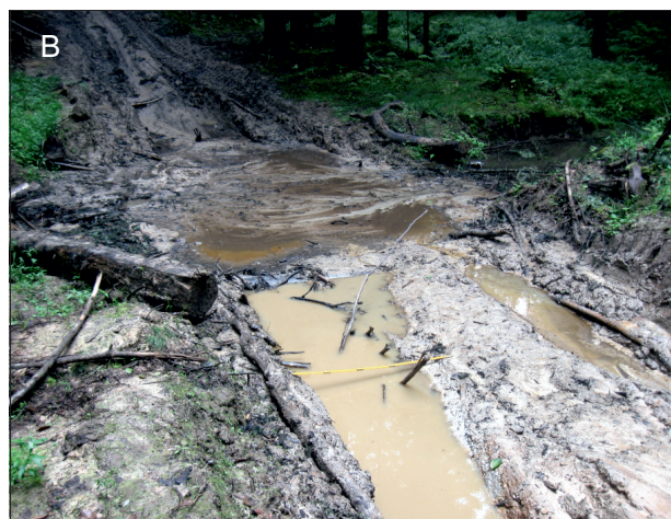
Ryc. 14. Zlewnia Leśnego Potoku. A. Miejsca połączeń drogi z ciekami (węzeł ciek–droga); B. Droga przecinająca koryto ciek, która jest intensywnie użytkowana podczas prac leśnych transportuje duże ilości materiału pyłowego, a ten z kolei zatrzymywany jest w korycie ciek (fot. A. Natanek)
