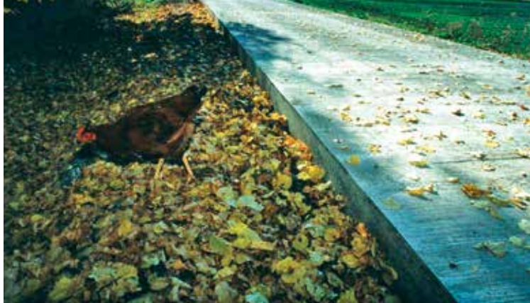
Wykonana nawierzchnia z betonu cementowego
