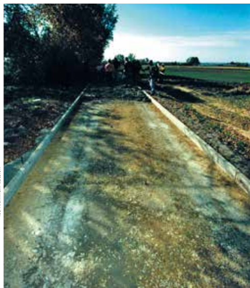
Droga przygotowana do ułożenia nawierzchni
