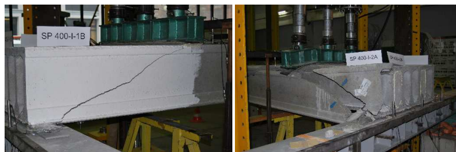
Rys. 7. Widok elementów opartych na podporze odkształcalnej po zniszczeniu a) niewypełnione kanały, b) wypełnione kanały
