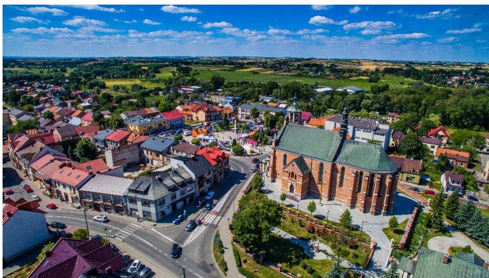
Rys. 5. Kościół w Proszowicach. Źródło: fot. Damian Król
