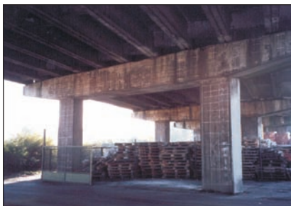
Fot. 4. Widok przyjętego do badań fragmentu konstrukcji (podpora nr 23)
