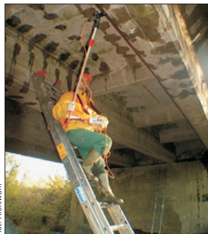
Fot. 3. Widok badanego fragmentu konstrukcji w czasie pomiarów
