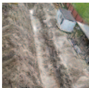
Rys. 18. Wykop pod drenaż zewnętrzny
