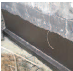
Rys. 20. Wykonana hydroizolacja zewnętrzna typu ciężkiego Superflex 10
