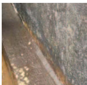
Rys. 22. Wykonane wyoblenie na styku ściany i płyty fundamentowej
