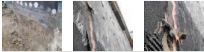
Rys. 7. Zły stan techniczny odkrytej izolacji zewnętrznej: kruchość, uszkodzenia mechaniczne
