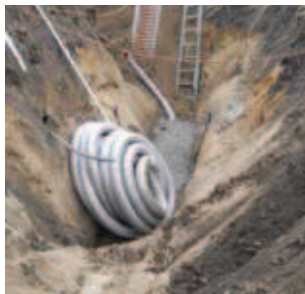
Rys. 15. Wykonanie tymczasowego drenażu zewnętrznego
