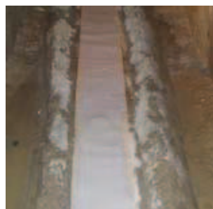
Rys. 25. Wykonane uszczelnienie dylatacji konstrukcyjnej wewnątrz budynku
