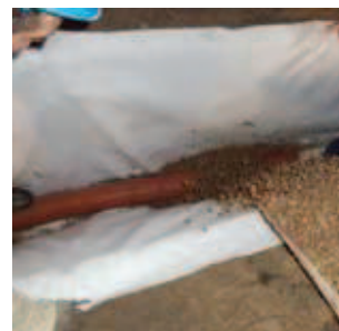
Rys. 17. Wykonany drenaż: geowłóknina, rura drenarska, kruszywo
