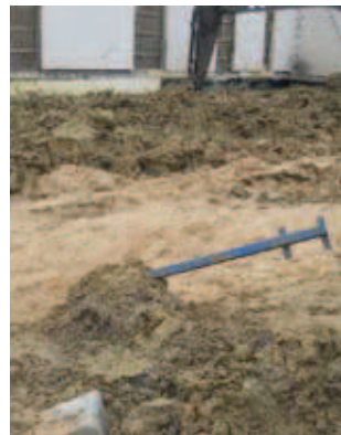
Rys. 6. Zasyпки wykonane gruntem niespoistym
