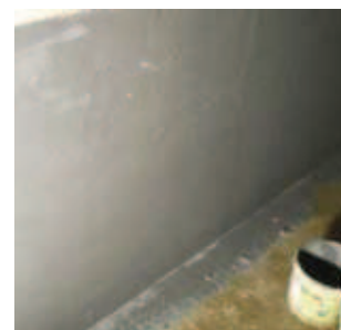
Rys. 26. Wykonana izolacja wewnętrzna
