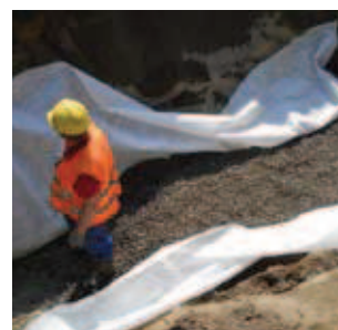
Rys. 19. Wykonany drenaż zewnętrzny: geowłóknina, kruszywo
