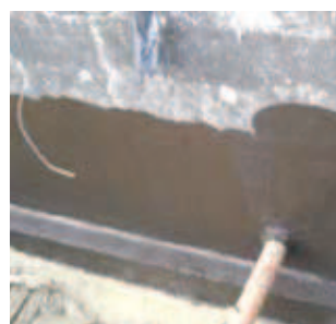
Rys. 23. Wykonana nowa warstwa izolacji zewnętrznej
