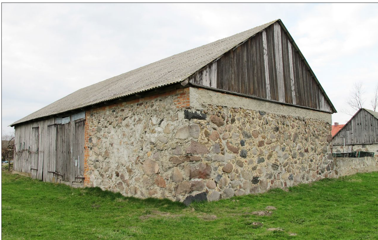
Ryc. 6. Dąbrówki – kamienna stodoła z grudkami rudy darniowej w spoinach pomiędzy kamieniami, rok 2010; fot. R. Piotrowski. Fig. 6. Dąbrówki—stone barn with bog ore fragments in the joints between stones, 2010; photo by R. Piotrowski.
