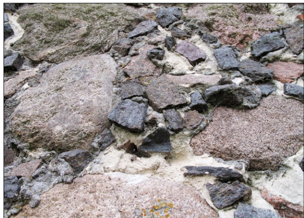
Ryc. 8. Rościszewo – zbliżenie na fragment ściany z widocznymi grudkami rudy darniowej, rok 2010; fot. R. Piotrowski. Fig. 8. Rościszewo—close-up of a wall fragment with visible bog ore fragments, 2010; photo by R. Piotrowski.
