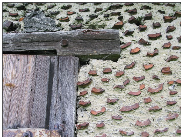
Ryc. 3. Zgagowo – zbliżenie na fragment ściany, rok 2010; fot. R. Piotrowski.
