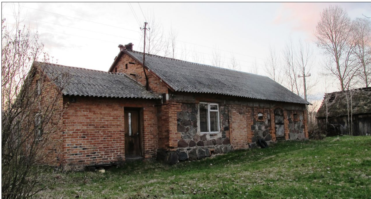
Ryc. 5. Topiąca – budynek mieszkalno-gospodarczy; w ściany wmurowano pojedyncze bloczki rudy darniowej, rok 2010; fot. R. Piotrowski. Fig. 5. Topiąca—residential and farm building; individual blocks of bog ore were incorporated into the wall, 2010; photo by R. Piotrowski.
