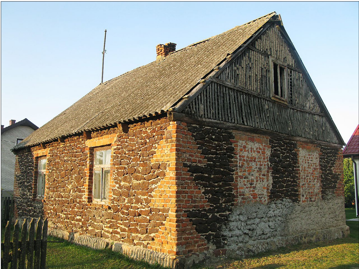
Ryc. 10. Pietrzyk – dom z rudy darniowej. Widoczny szczyt dachu pierwotnie wykonany z gliny, rok 2018; fot. R. Piotrowski. Fig. 10. Pietrzyk—bog ore house. View of a roof gable initially made from clay, 2018; photo by R. Piotrowski.
