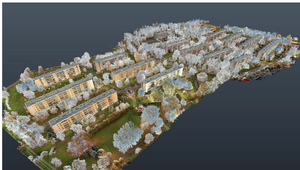
Rys. 3. Widok chmury punktów – wynik skanowania 3D kwartału zabudowy
