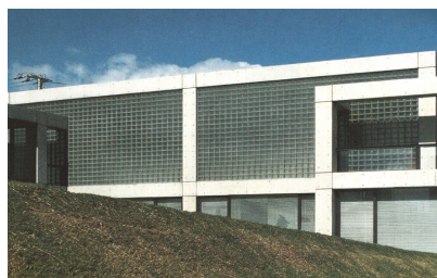
Ryc. 23. Matsumoto House, Wakayama. Tadao Ando. Elewacja. Źródło: Wigginton Michael: Glass in architecture . Wyd. Phaidon 1996r.
