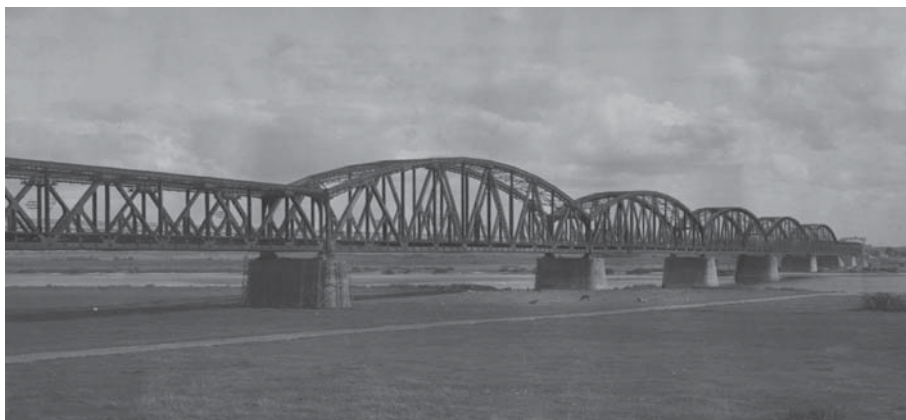
Fot. 7. Konstrukcja stalowa niemieckiego mostu przez Wisłę w Opaleniu przed rozbiórką, Koncern Ilustrowany Kurier Codzienny – Archiwum Ilustracji (Narodowe Archiwum Cyfrowe, sygn. 1-G-3464)
