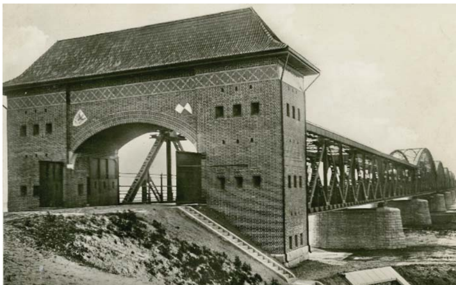
Fot. 6. Brama wjazdowa na most przez Wisłę w Opaleniu na niemieckiej pocztówce bez obiegu (zbiór autora)
