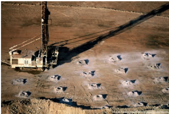
Ryc. 6. Wiercenie otworów strzałowych w systemie wieloszeregowym [11]
