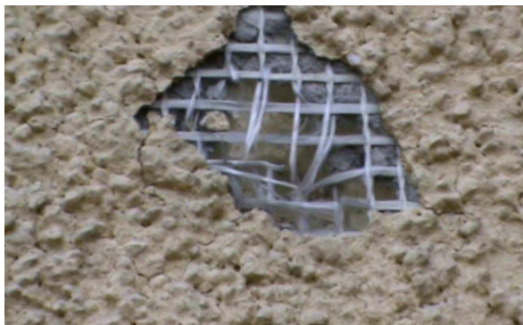
Rys. 9. Wadliwie ułożona siatka w warstwie zbrojącej
