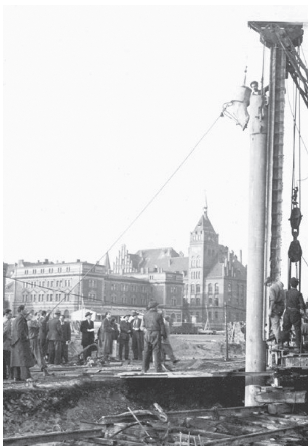
Rys. 3. Początek budowy siedziby Wydziału Górniczego – osadzanie betonowych pali
