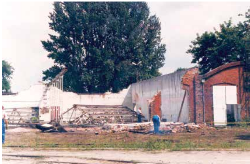
Rozbiórka lokomotywni cukrowni Kruszwica. Fot. A. Ciechański, lato 2003
