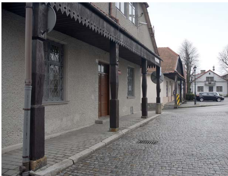
Ryc. 3. Stary budynek Urzędu Gminy (pot. „stara gmina”) – wg miejscowych cieśli posiada słupy o wzorcowych proporcjach Fig. 3. Old building of the Commune Office (coll. “stara gmina”) – has columns with model proportions acc. to local carpenters
