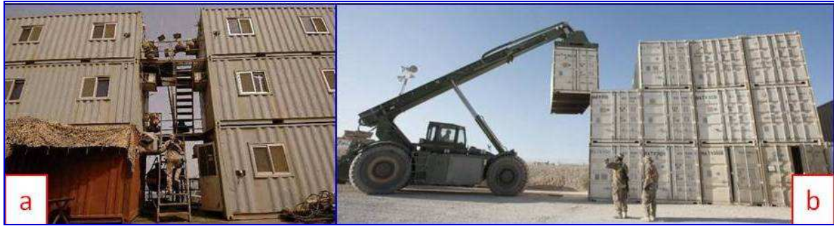
Rys. 1. Dzięki konteneryzacji, wojsko zysało możliwość szybkiego zakładania baz, a) segmenty mieszkalne, b) segmenty, z które mogą służyć jako warsztaty, cysterny, stanowiska ogniowe, segmenty sanitarne, szpitalne. [1]
