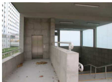
Fot. 8. Przejście przy ul. Ostrowskiej – dojście do windy od strony południowej
