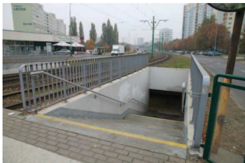
Fot. 5. Przejście Lecha-Czecha – typowe wyjście na przystanek tramwajowy (ok.2,9m)
