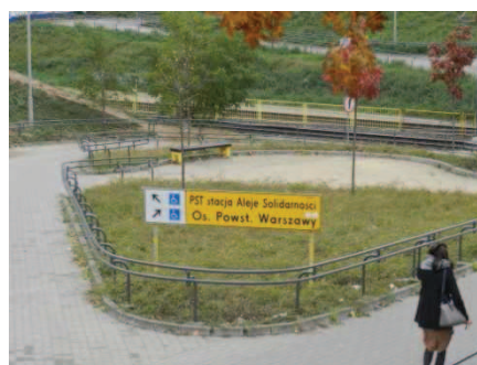
Fot. 15. Przejście przy Alejach Solidarności – pochyłe chodniki jako dojścia do tuneli
