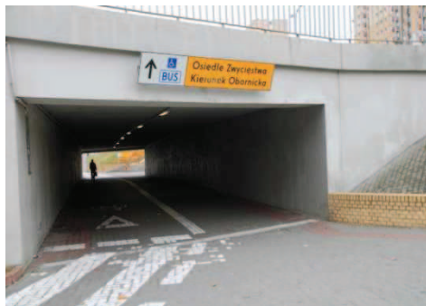
Fot. 9. Przejście przy Alejach Solidarności – tunel z umownym rozdzieleniem skrajni ruchu pieszych i rowerzystów
