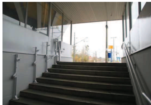
Fot. 10. Przejście Górczyn – wyjście pośrednie na perony – konstrukcja przygotowana do montażu ruchomej platformy
