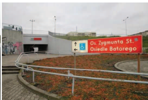
Fot. 22. Przejście przy ul. Szymanowskiego – oznakowanie kierunków poruszania się osób niepełnosprawnych
