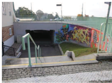
Fot. 20. Przejście przy ul. Wieżowej – wejście do tunelu od strony ul. Panny Marii ze ścianą oporową pokrytą graffiti
