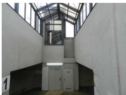
Fot. 14. Przejście przy ul. Leszka – winda między ul. Warszawską i linią kolejową
