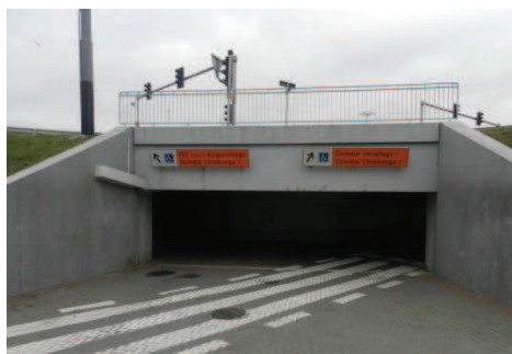
Fot. 21. Przejście przy ul. Kurpińskiego – oznakowanie kierunku poruszania się osób niepełnosprawnych
