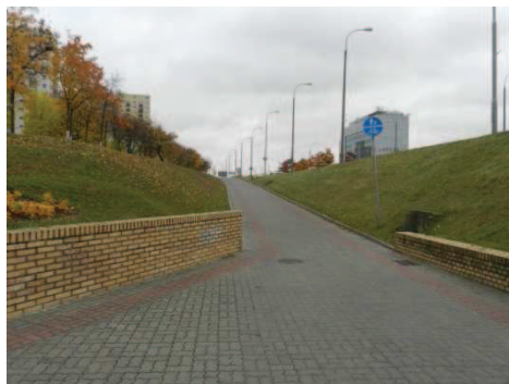
Fot. 16. Dojście do przejścia przy Al. Solidarności – widok na pochyły chodnik (pochylenie <math><6,0\%</math>), brak poręczy i balustrad
