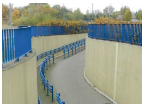
Fot. 12. Przejście Fabianowo – widok na pochylnię północno-zachodnią
