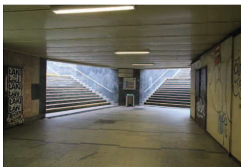
Fot. 7. Przejście przy ul. Towarowej – rozgałęzienia tunelu od strony północnej
