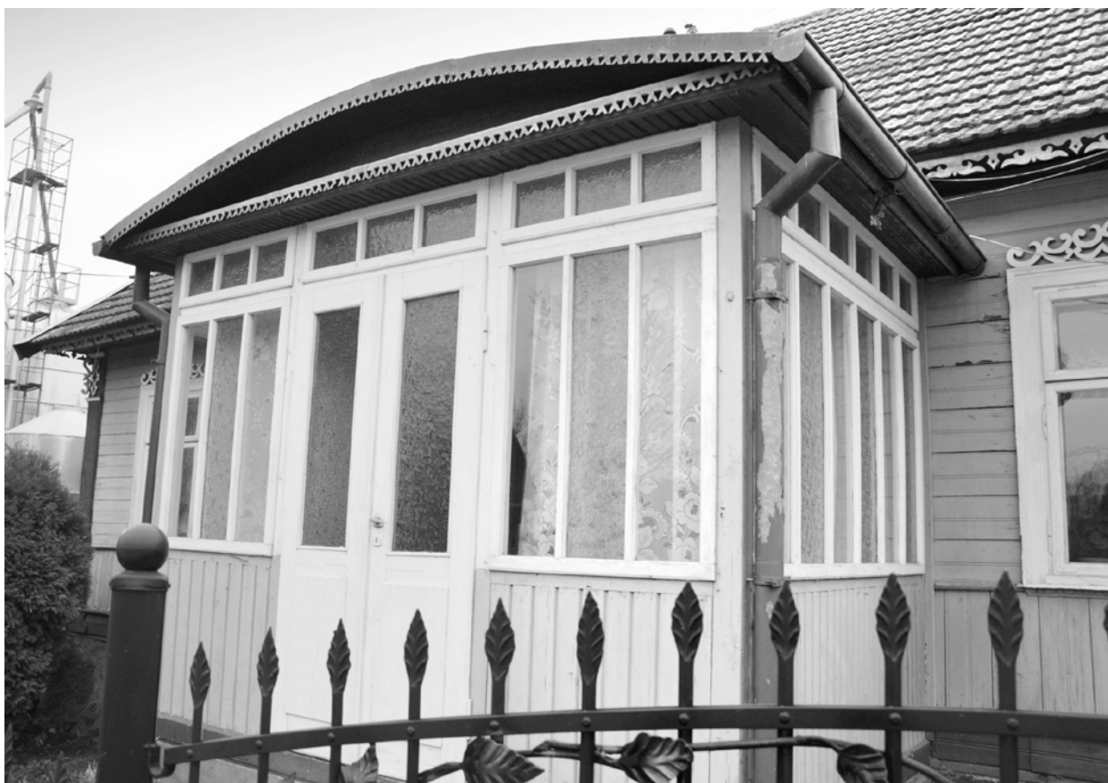
Fig. 9. The front porch glazed with stained glass; photo by the authors, 2018 Ryc. 9. Frontowa weranda szklona witrażowo; fot. autorzy, 2018
