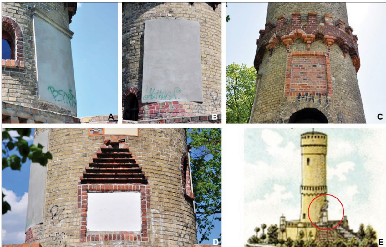
Ryc. 5. Detale dolnej części trzonu wieży; A – płyca od strony wsch., prawdopodobnie po żelwnej płycie inskrypcyjnej, B – płyca od strony zach., prawdopodobnie po żelwnej płycie inskrypcyjnej, C – nisza po tablicy inskrypcyjnej od strony płn.-zach., D – nisza po tablicy inskrypcyjnej od strony pd.-wsch., E – zaznaczona rzeźba orła nad niszą pd.-wsch. na pocztówce z 1904 r.
