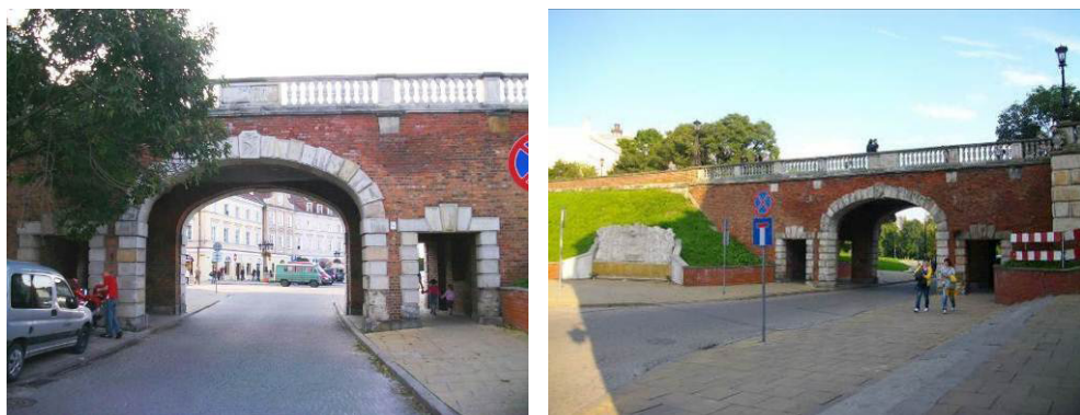
Fot. 4. Widok wiaduktu od strony Placu Zamkowego i od strony ulicy Podwale [4].
