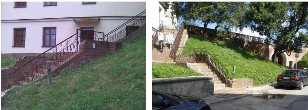
Fot. 7. Schody od ulicy Podwale [4].
