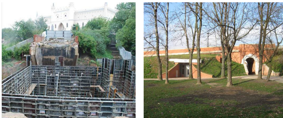
Fot. 19. Budowa szaletu miejskiego [4 i 5].
