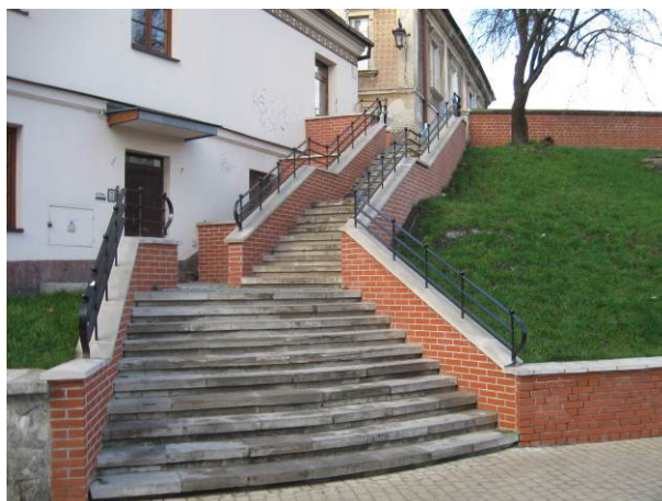
Fot. 21. Nowe schody od strony ul. Podwale [4].
