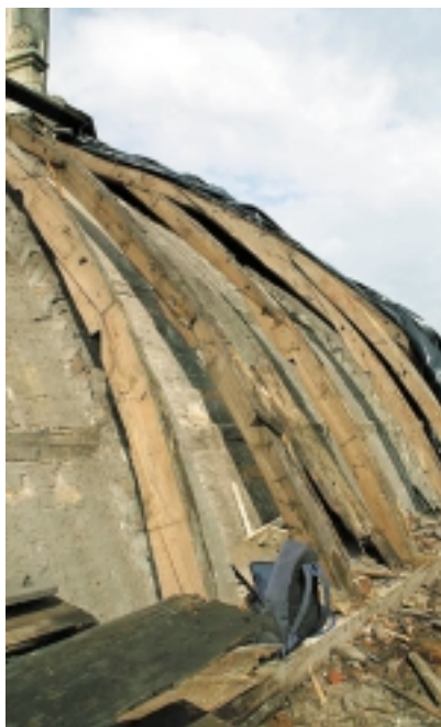
Rys. 17. Kopuła – drewniana konstrukcja dachu pod pokrycie
