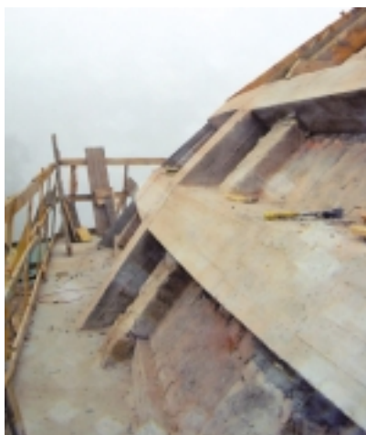
Rys. 22. Wykonane dolne równoleżnikowe wraz z fragmentem jednego z łąber południkowych
