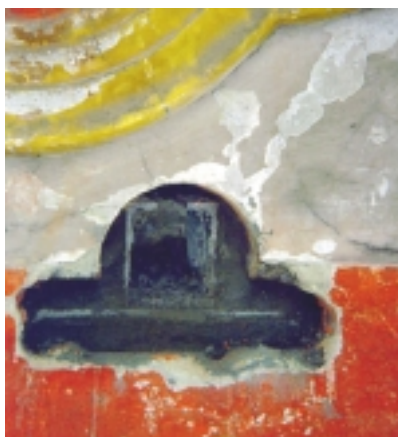
Rys. 25. Osadzone elementy wsporcze w ścianach latarni – widok od wnętrza latarni
