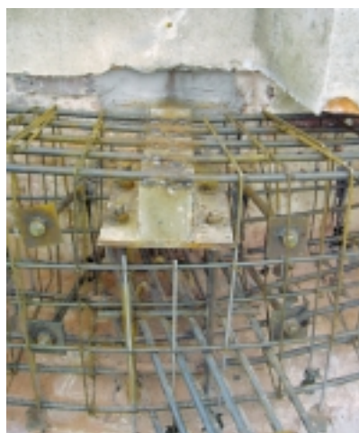
Rys. 29. Pierścień górny ściskany. Widoczny stalowy element wsporczy osadzony w ścianie latarni, przygotowany do zabetonowania
