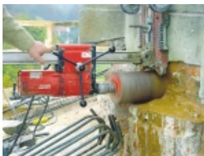
Rys. 26. Faza wykonania odwiertów dla osadzenia elementów wsporczych w ścianie latarni
