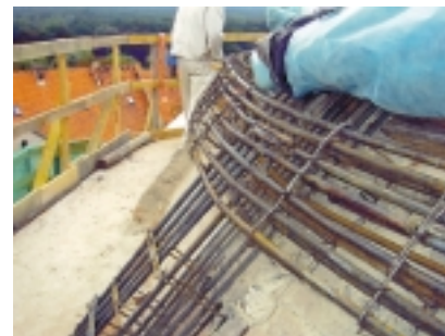
Rys. 20. Zbrojenie pierścienia dolnego, rozciąganego
