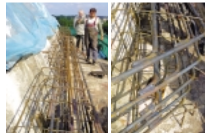
Rys. 20. Zbrojenie pierścienia dolnego, rozciąganego
