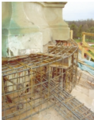
Rys. 28. Zbrojenie pierścienia górnego, ściskanego
