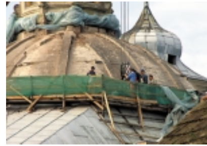
Rys. 18. Kopuła ceglana z żebrami w widoku z zewnątrz
