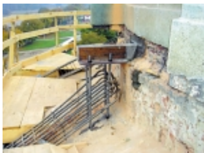
Rys. 24. Osadzenie elementów wsporczych w ścianach latarni wraz z zakotwieniem, przy użyciu techniki klejenia w powłoce ceglanej kopuły. Elementy przygotowano do zabetonowania w żelbetowym pierścieniu ściskanym
