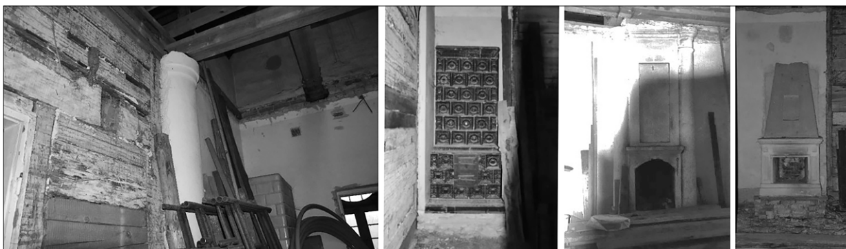
Ryc. 6. Zachowane półkolumny w korytarzu, piec i kominki, 2021; fot. autorzy.
