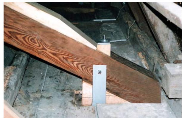
Ryc. 25. Szczegół wzmocnienia węzła podporowego w trakcie wykonywania prac
