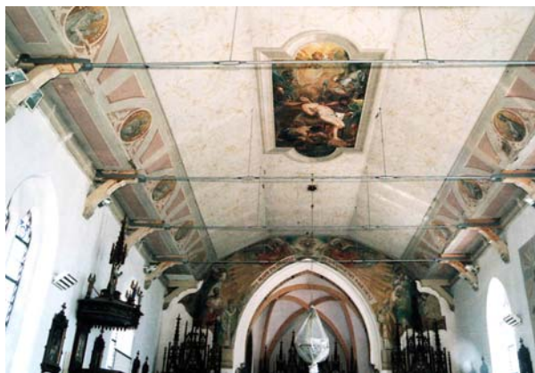
Ryc. 29. Wnętrze nawy po zainstalowaniu ściągow
