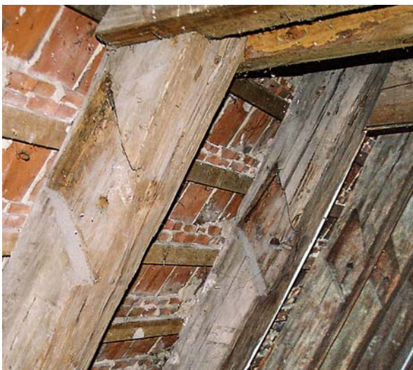
Ryc. 2. Gniazda w krokwiach w starszej części nawy po usunięciu zastrzałów podporowych Fig. 2. Sockets in the rafters in the older nave fragment where the support braces were removed
