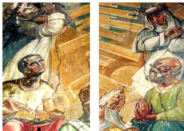
Ryc. 17. Zarysowane fragmenty ściany tęczowej, fot. Grzegorz Nowak
