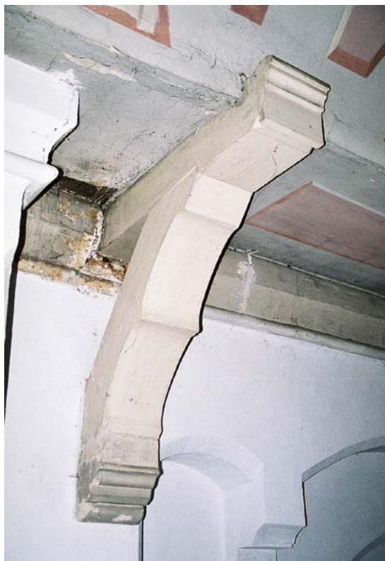
Ryc. 14. Konsola wspierająca pseudokopułę Fig. 14. Console supporting pseudo-vaulting
