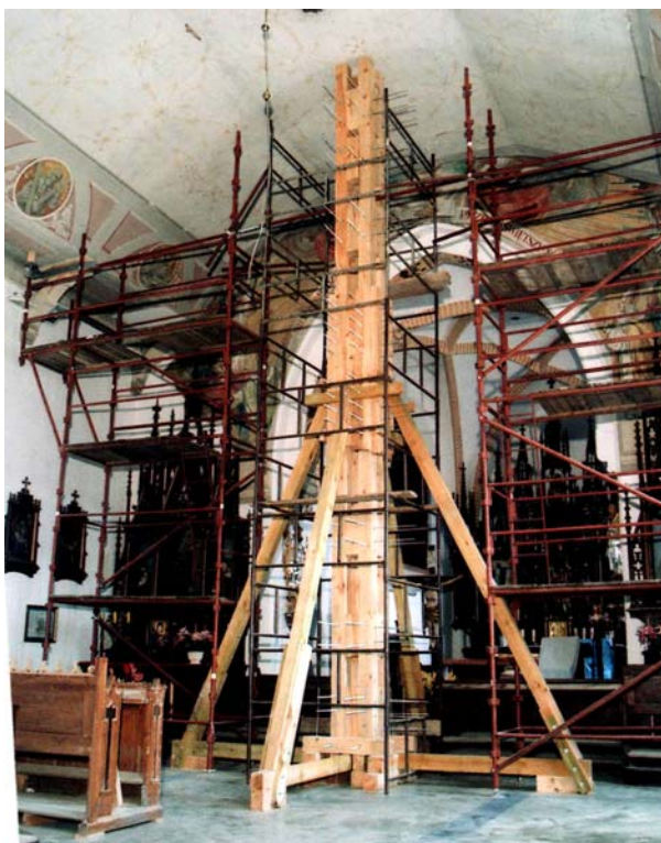
Ryc. 27. Słup do podparcia i uniesienia węzła centralnego przed montażem ściągow
