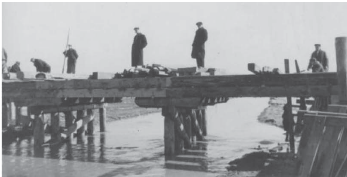
Rys. 16. Most w ciągu u. Pawiej w Lublinie: a) budowa pomostu, b) kształtowanie skarp i skrzydeł przyczółków (foto: Teatr NN w Lublinie)
