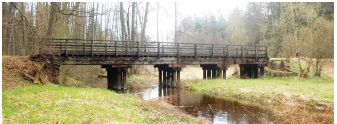
Rys. 1. Most drewniany przez rzekę Branew (2022), wiosna: a) widok od strony górnej wody – GW, b) widok mostu od strony dolnej wody – DW
