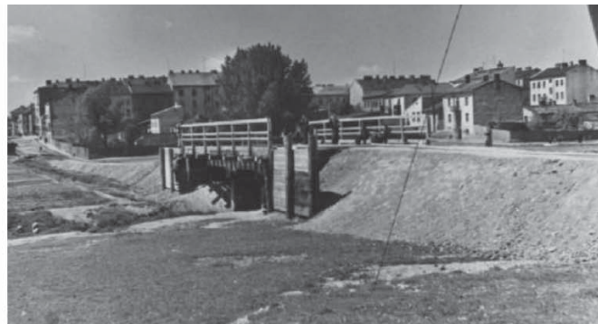
Rys. 16. Most w ciągu u. Pawiej w Lublinie: a) budowa pomostu, b) kształtowanie skarp i skrzydeł przyczółków (foto: Teatr NN w Lublinie)
