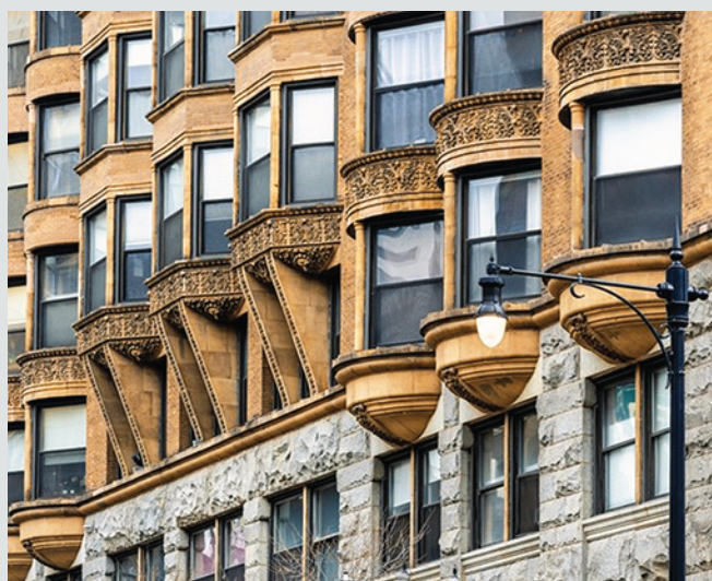
Fot. 19. Wykusze z oknami chicagowskimi, Manhattan Building, projekt William Le Baron Jenney, Chicago 1891 r., źródło: Wikimedia Commons
