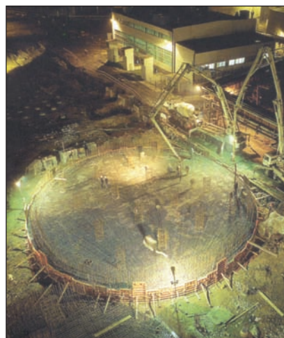
Betonowanie ciągłe prowadzone przez BT Gliwice w elektrowni łaziska
