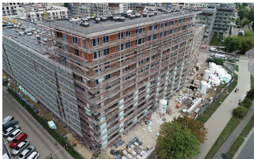
Rys. 1. Widok ogólny na analizowane rusztowanie [5]
