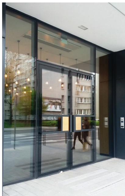
Fot. 11. Brama wejściowa do budynku Wyszyńskiego 56; proj. Maćków Pracownia Projektowa, 2022 r.; źródło: fot. autorka
