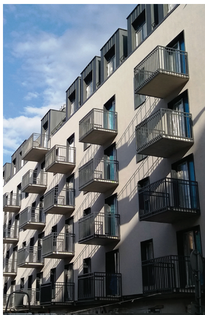
Fot. 13. Długie cienie balkonów na fasadzie budynku powstającego przy ul. Mikotaja Reja 55; źródło: fot. autorka
