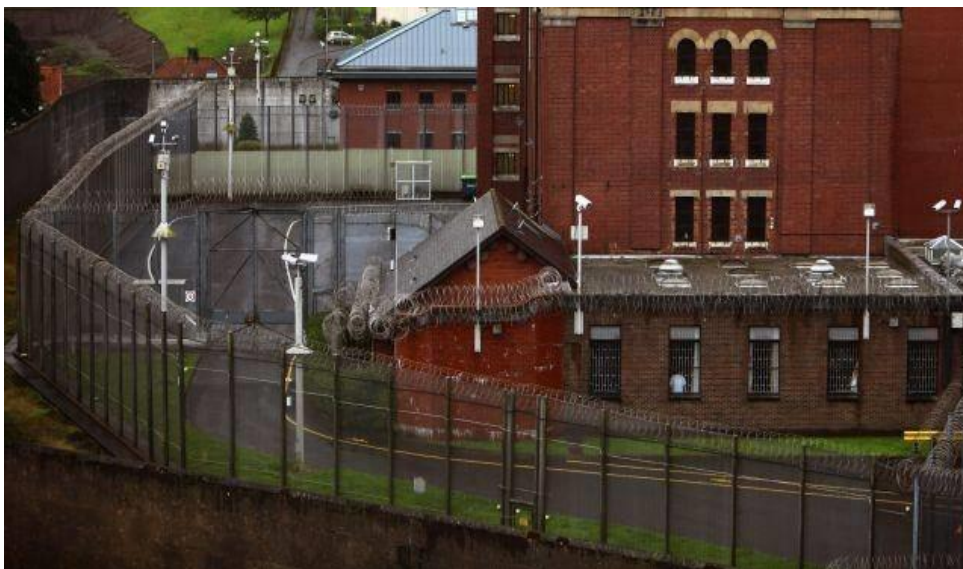
Rysunek 3. Fizyczne środki wykorzystane do ochrony obiektu (wysokie ogrodzenie, concertina, dodatkowe oświetlenie i kamery).
