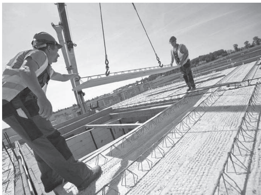
Rys. 1. Strop panelowy Vector; źródło [5]
