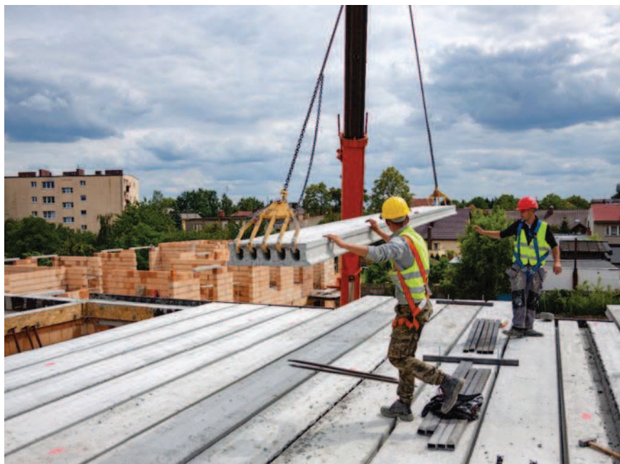
Rys. 2. Strop panelowy Smart; źródło [5]
