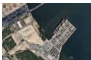
Rys. 1. Terminal DCT przed rozbudową
