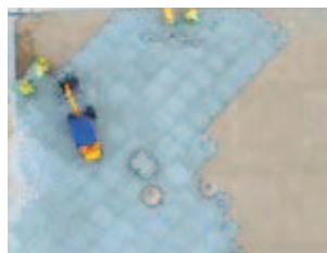
Rys. 10. Układanie nawierzchni z kostki
