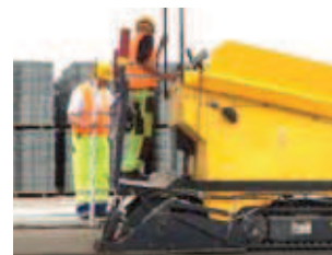
Rys. 11. Układanie podsypki piaskowej
