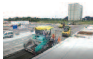
Rys. 8. Układanie podbudowy z MZC
