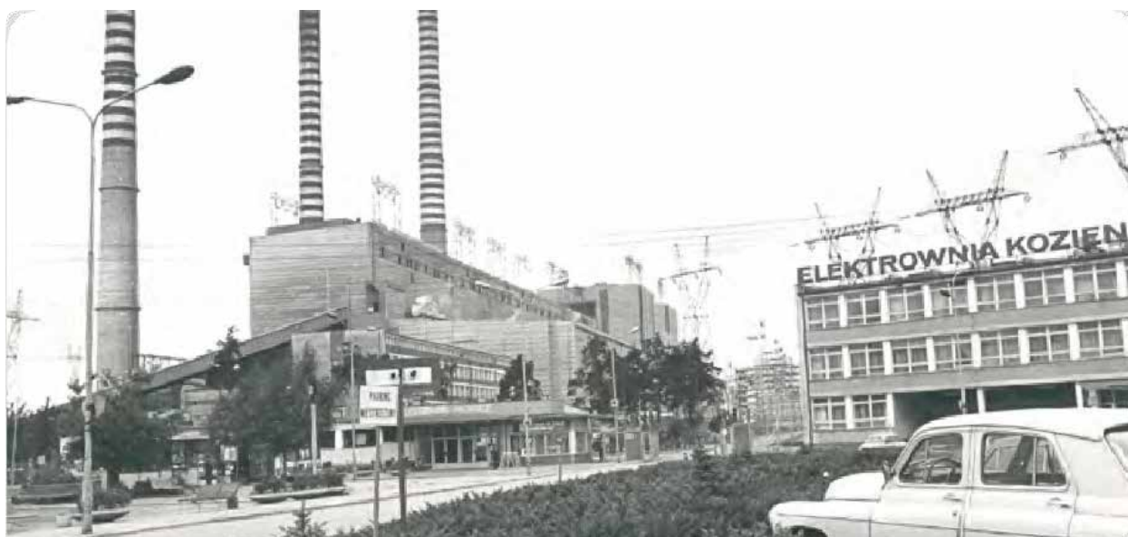
Lata 70. i 80. to okres intensywnego rozwoju Elektrowni Kozienice, a kolejne dekady to czas przemian w kierunku nowoczesnej elektrowni, zapewniającej bezpieczeństwo energetyczne kraju
