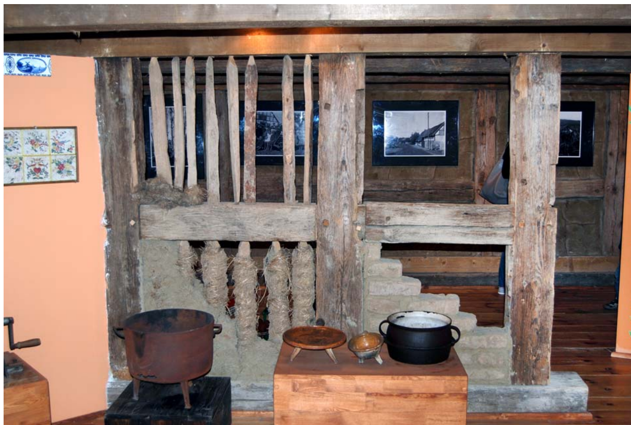
Ryc. 6. Ekspozycja pokazująca metody wypełniania ścian budynków w konstrukcji szkieletowej – archiwum autora Fig. 6. Exhibit demonstrating methods of infilling building walls in a frame construction – author's archive
