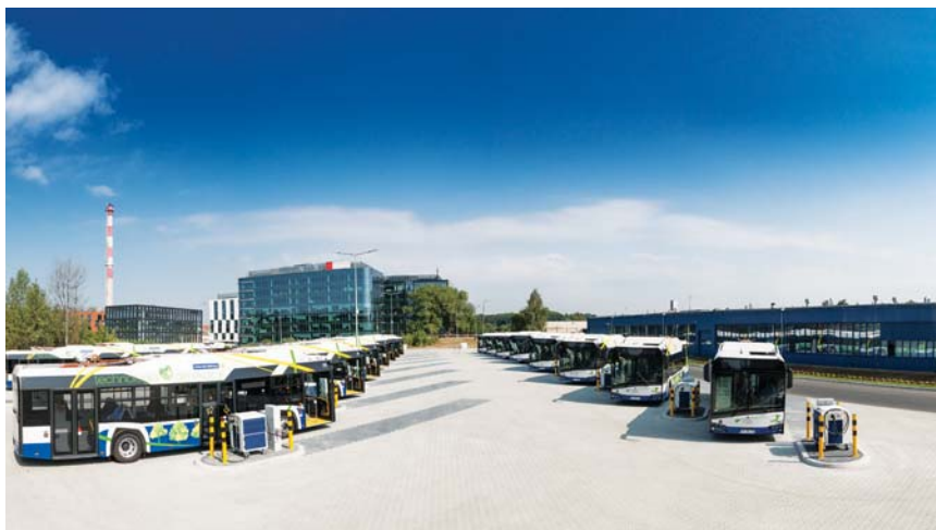
Do uzupełniania energii elektrycznej w nowych Solarisach Urbino 12 electric dla MPK wykorzystywane są ładowarki firmy Medcom
