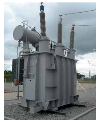
Rys. 5. Dławik 145 kV, 11,4 MVA, który pracował w Brazylii jako jednostka swobodnie oddychająca przez ponad 7 lat
