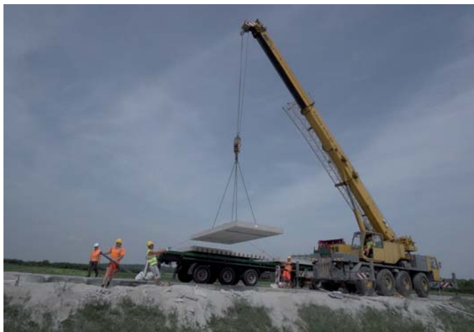
Fot. 3. Prefabrykat w trakcie wbudowania
