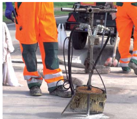
Fot. 4. Tłoczenie geopolimeru pod płytę
