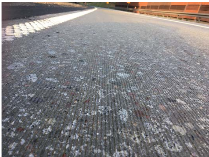
Fot. 5. Tekstura nawierzchni po nacinaniu metodą grinding
