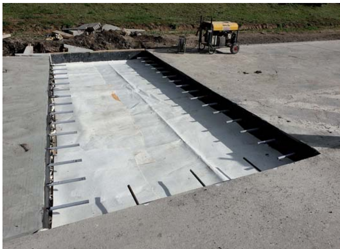
Fot. 1. Miejsce przygotowane do odtworzenia płyty w technologii betonu szybkostrawnego
