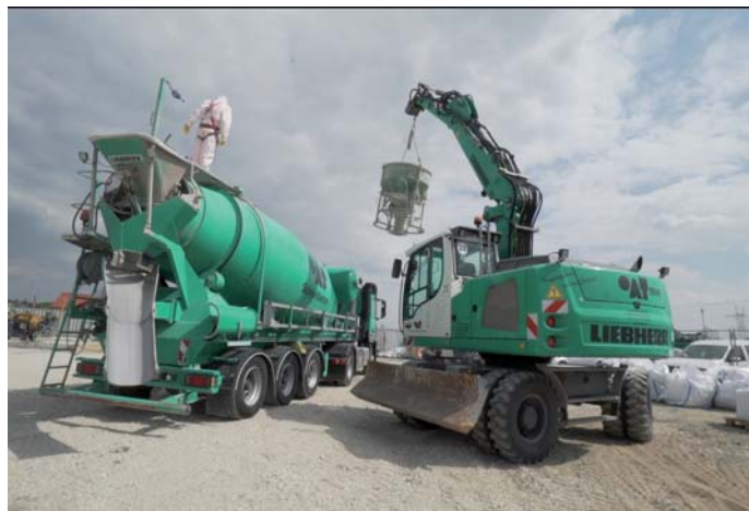
Fot. 2. Załadunek mobilnej wytwórni na zapleczu budowy
