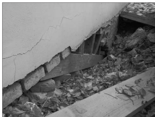
Ryc. 1. Przykład hydrokompakcji w starym zasypanym kanale w centrum Krakowa. Fot R. Kaczmarczyk
