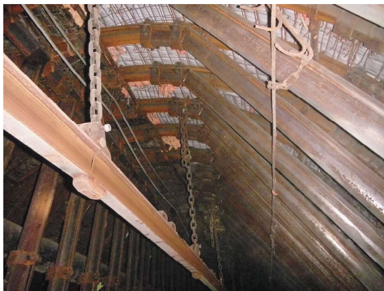
Rys. 12. Obudowa chodnika 332 (metraż 180 m)
