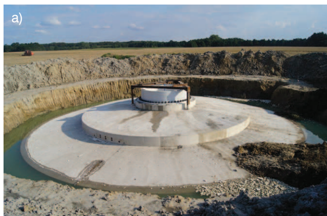
Rys. 1. Fundament wieży turbiny wiatrowej: a) widok ogólny, b) stan fundamentu po zalaniu wodą gruntową
