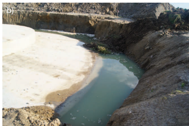
Rys. 1. Fundament wieży turbiny wiatrowej: a) widok ogólny, b) stan fundamentu po zalaniu wodą gruntową
